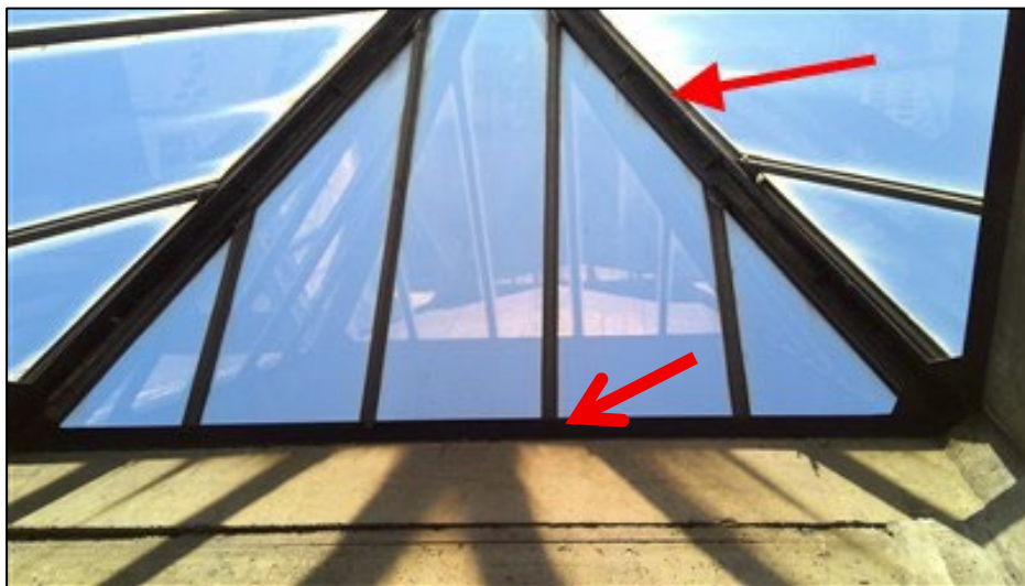
Figure 1 - Localisation des tresses amiantés sur les lanterneaux (source RAAT ADX – Août 2025)
