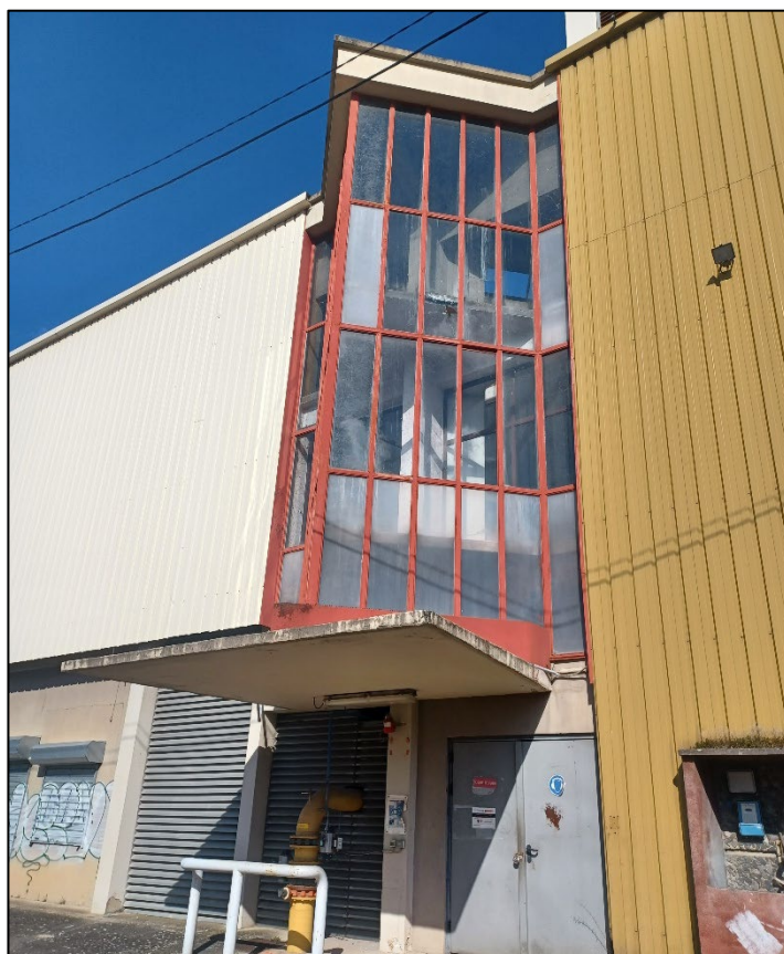
Figure 6 - Verrière concernée par la repose de vitrage suite au désamiantage du lot 01
